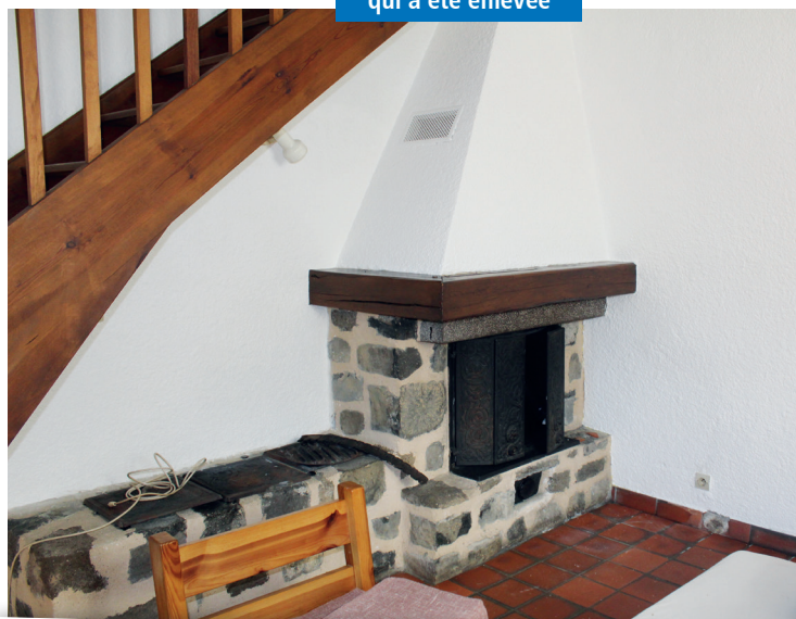
La cheminée qui a été enlevée
