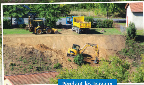
Pendant les travaux
