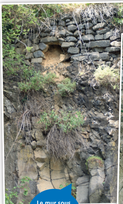
Le mur sous le cimetière des moines AVANT
