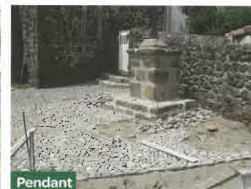
Travaux de mise en place des galets éclatés par l'entreprise Durand Pavage
