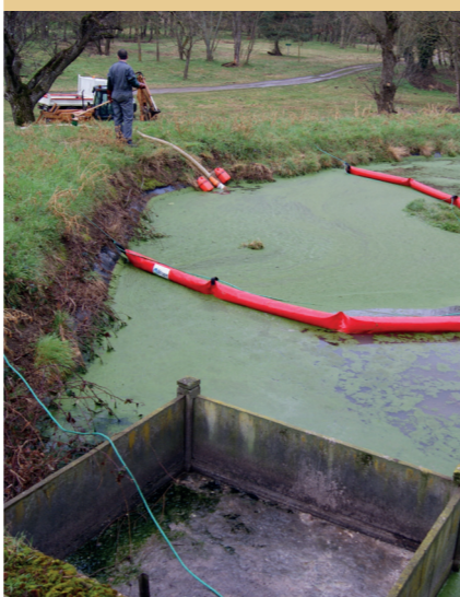
Concentration des végétaux dans une partie du bassin grâce à un boudin anti pollution puis récolte manuelle et pompage.
